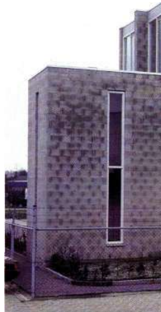
De gesloten achtergevel met terras te Lichtenvoorde. Hiernaast het atelier met de rode trap naar de entresol.
