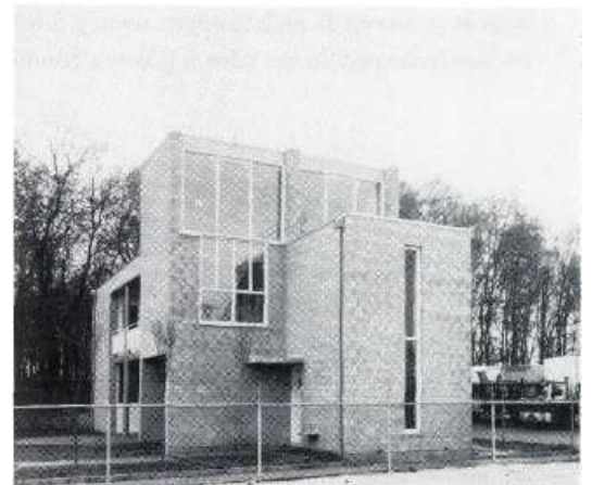
De 'trappetoren' voor het hoge atelier.
