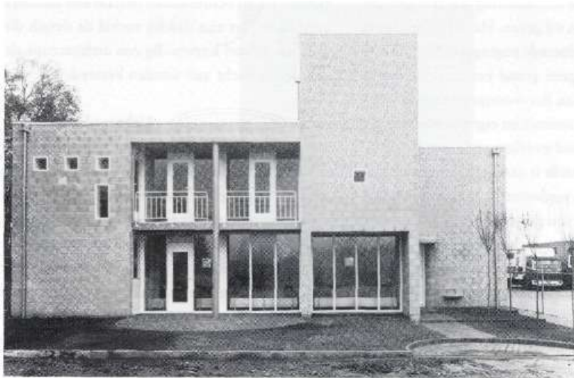
Voorgevel met dubbelhoog atelierblok
