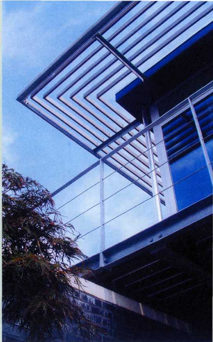
Het overstek kreeg lamellen van western red cedar.
